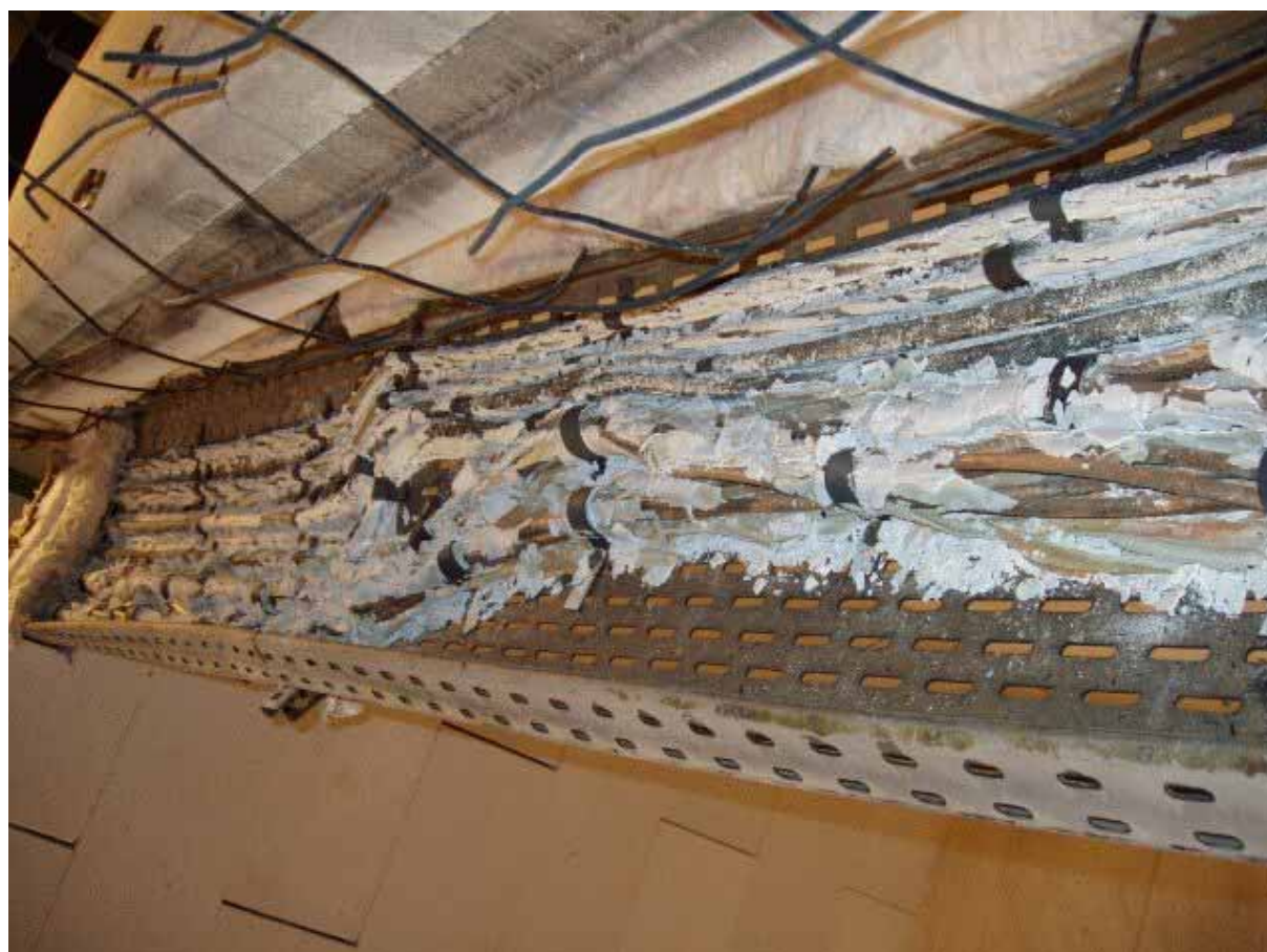
Slika 7. Slika kabelske trase po završetku ispitivanja.
