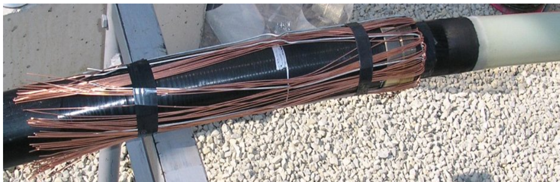
Priprema VN kabela za spajanje
